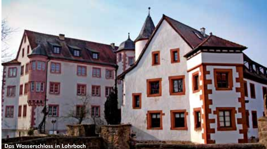
Das Wasserschloss in Lohrbach
